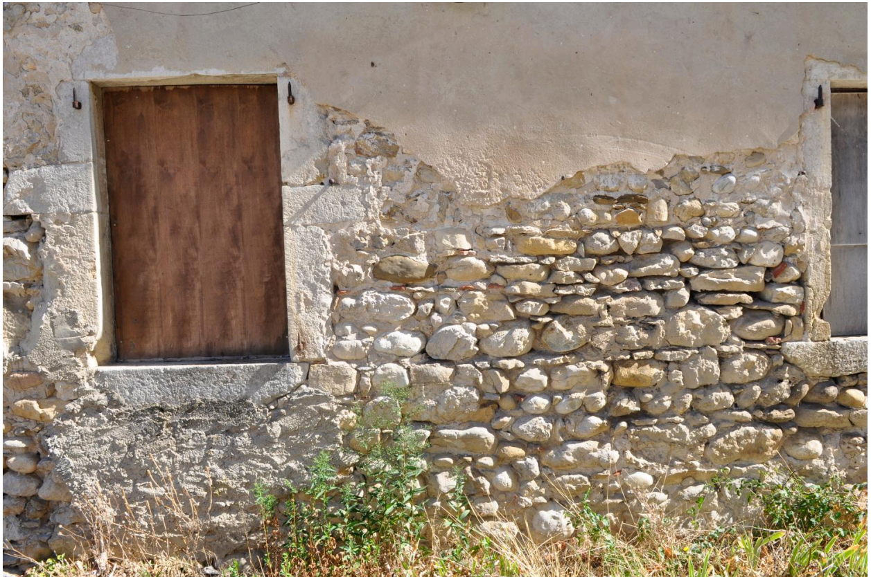
Détail de la maçonnerie en façade
