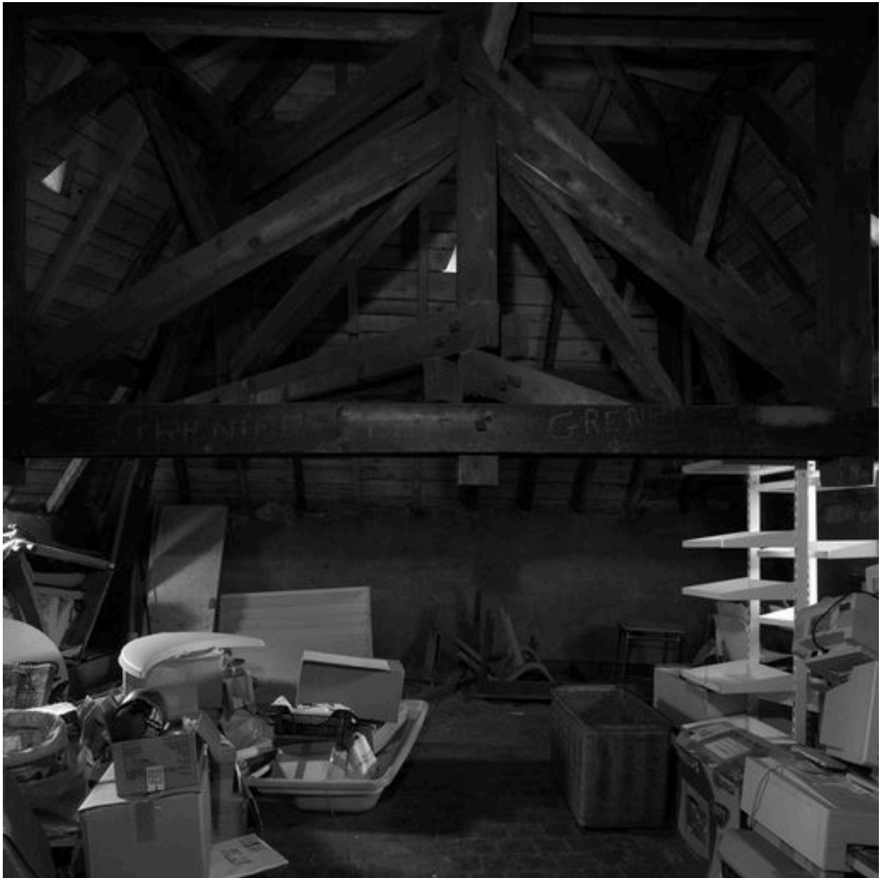
Grenier de l'école de garçons, charpente au dessous du toit à croupe
