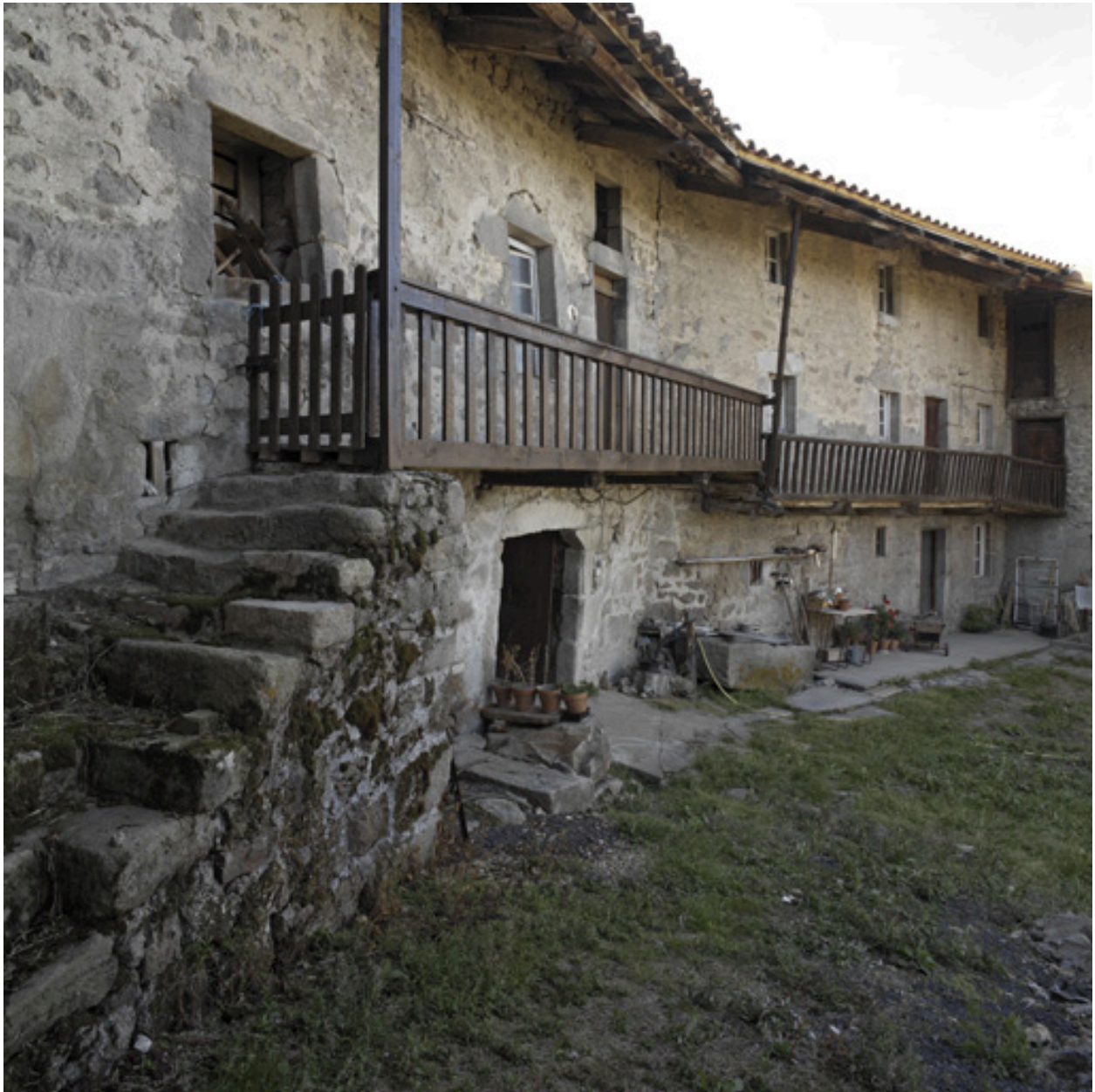
Vue d'ensemble de l'étable et du logis, depuis l'angle sud-ouest de la cour.
