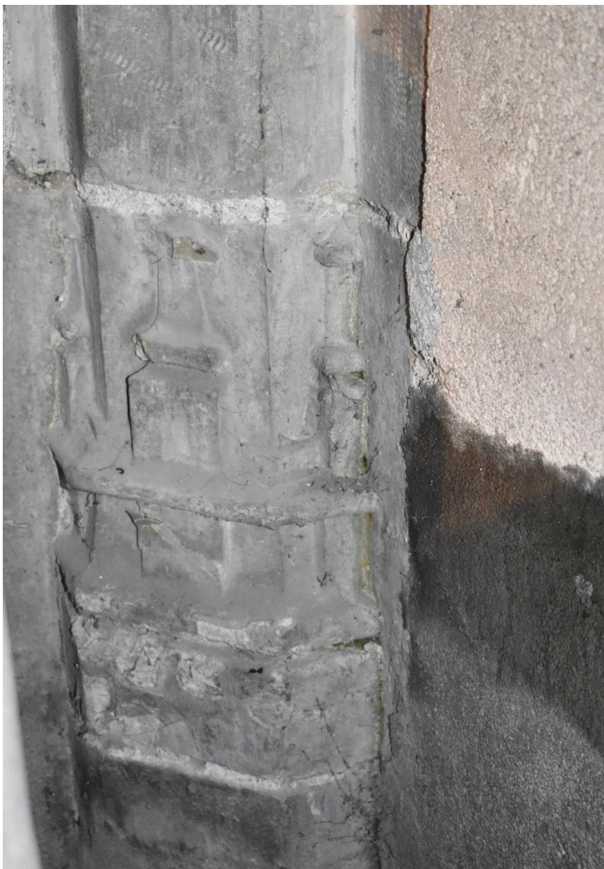
Détails des bases d'arcs et nervures à l'angle nord-ouest de la chapelle de la Beaume.
