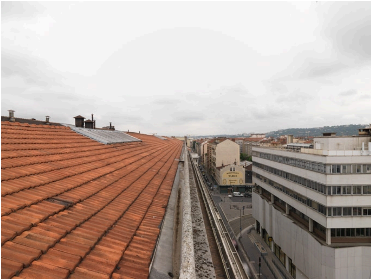
Détail toiture : lanterneau et chéneaux
