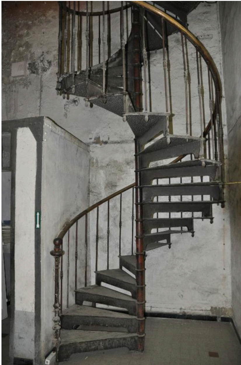
Vue de l'escalier à vis de la centrale de Livet
