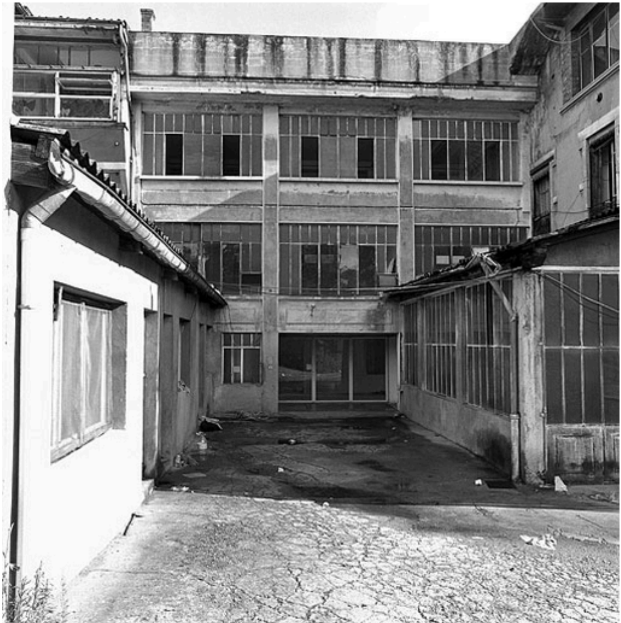
Vue est des ateliers
