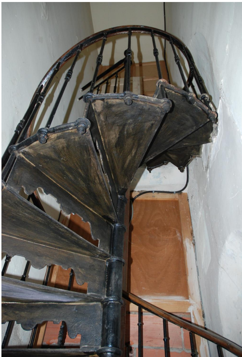
Vue intérieure : escalier secondaire en vis métallique.
