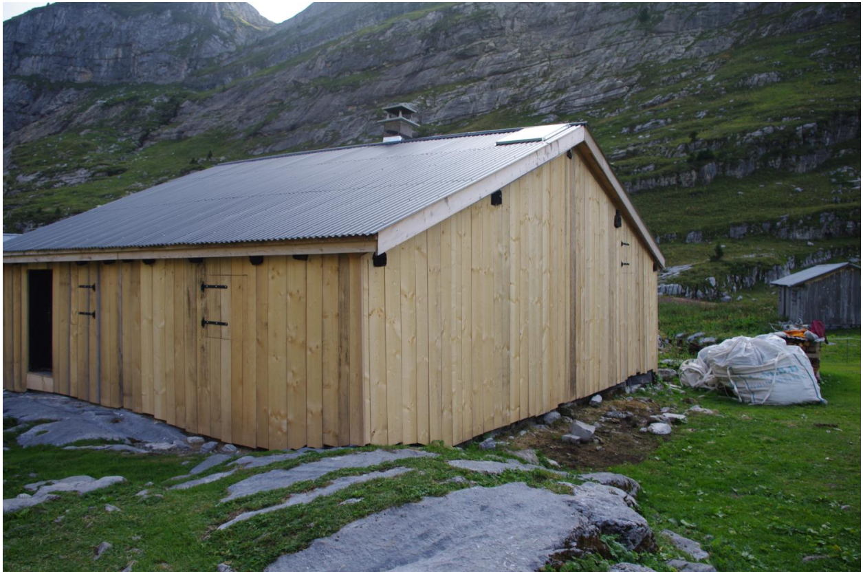
Vue de l'élévation nord est
