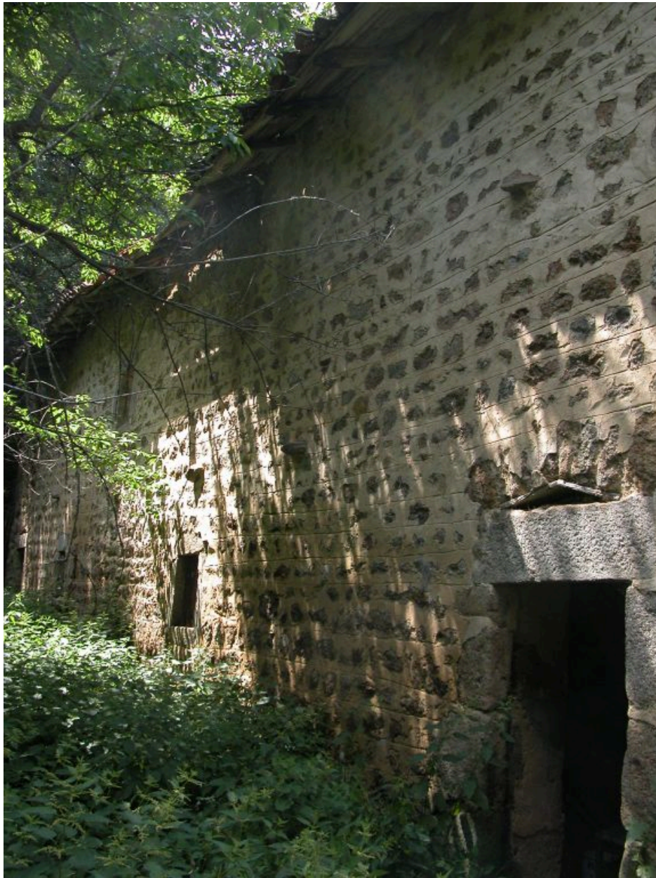
Mur gouttereau sud, baies de l'étable.
