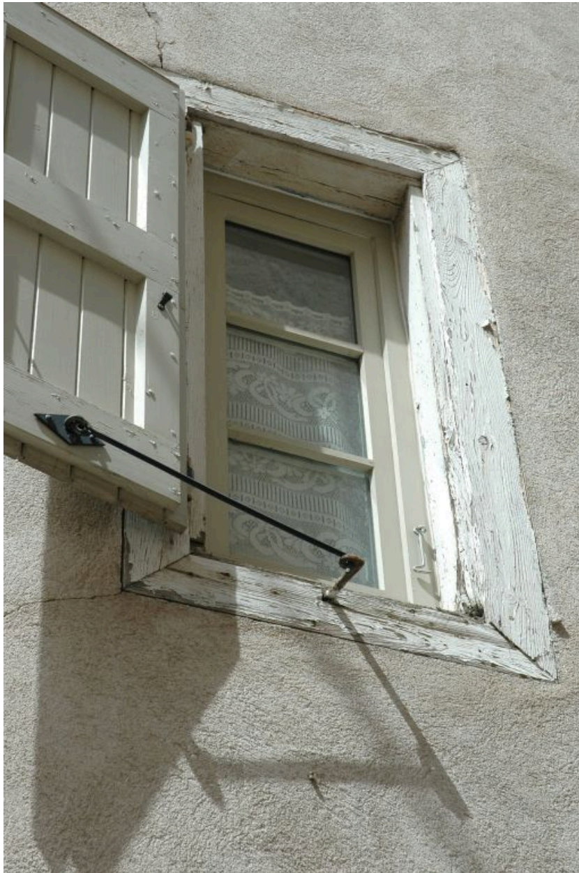
Elévation latérale, ancienne fenêtre à traverse avec embrasure extérieure en bois.
