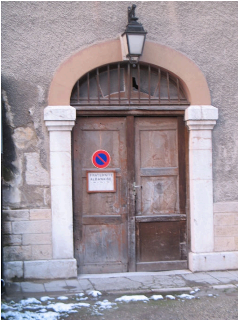
Entrée principale aile nord
