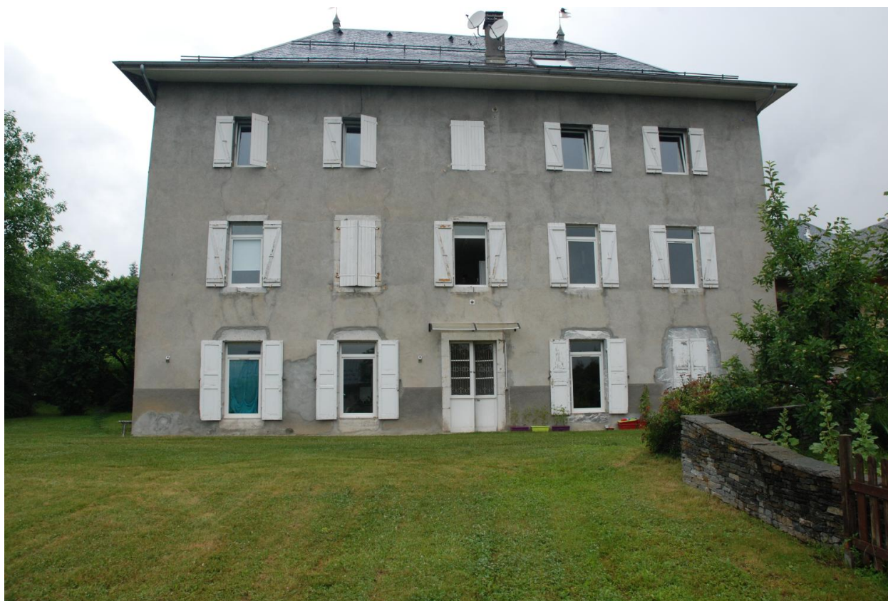
Demeure, façade sud.
