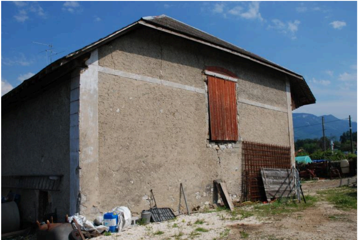
Vue du bâtiment principal, depuis le nord-ouest.
