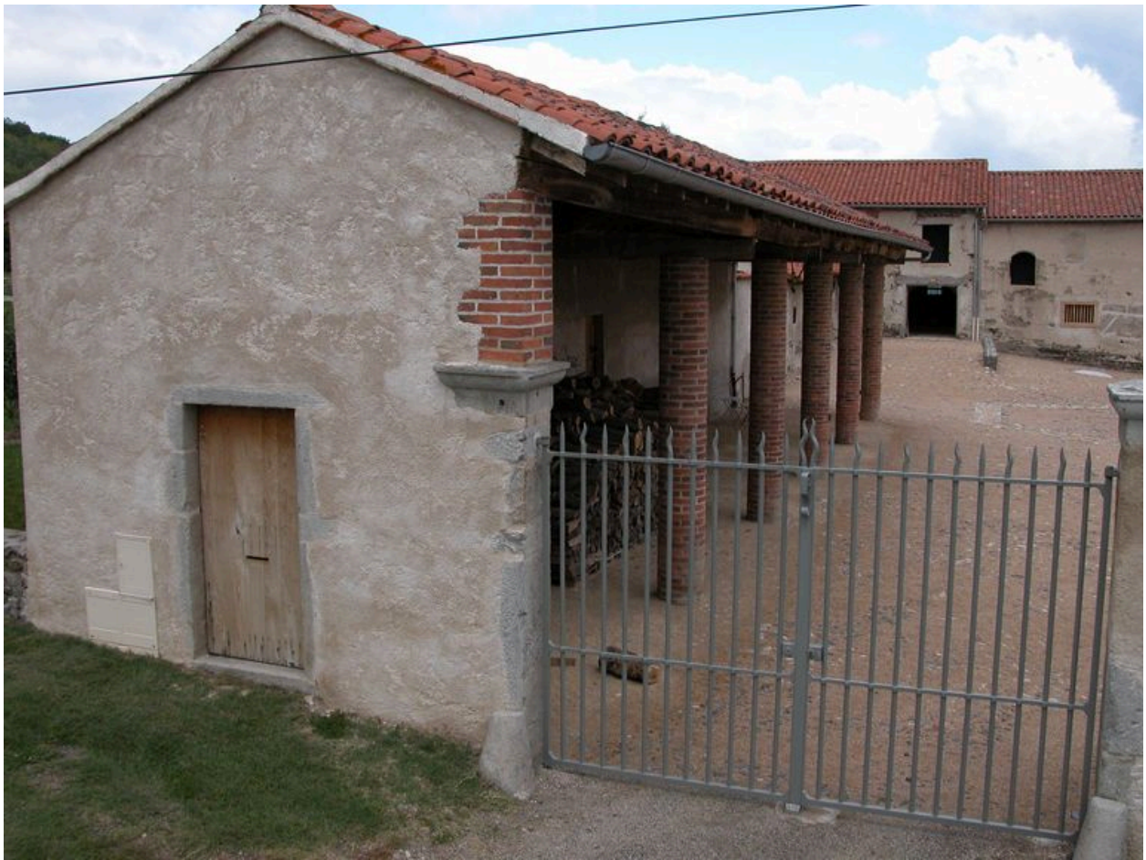
Vue du hangar, depuis le sud.
