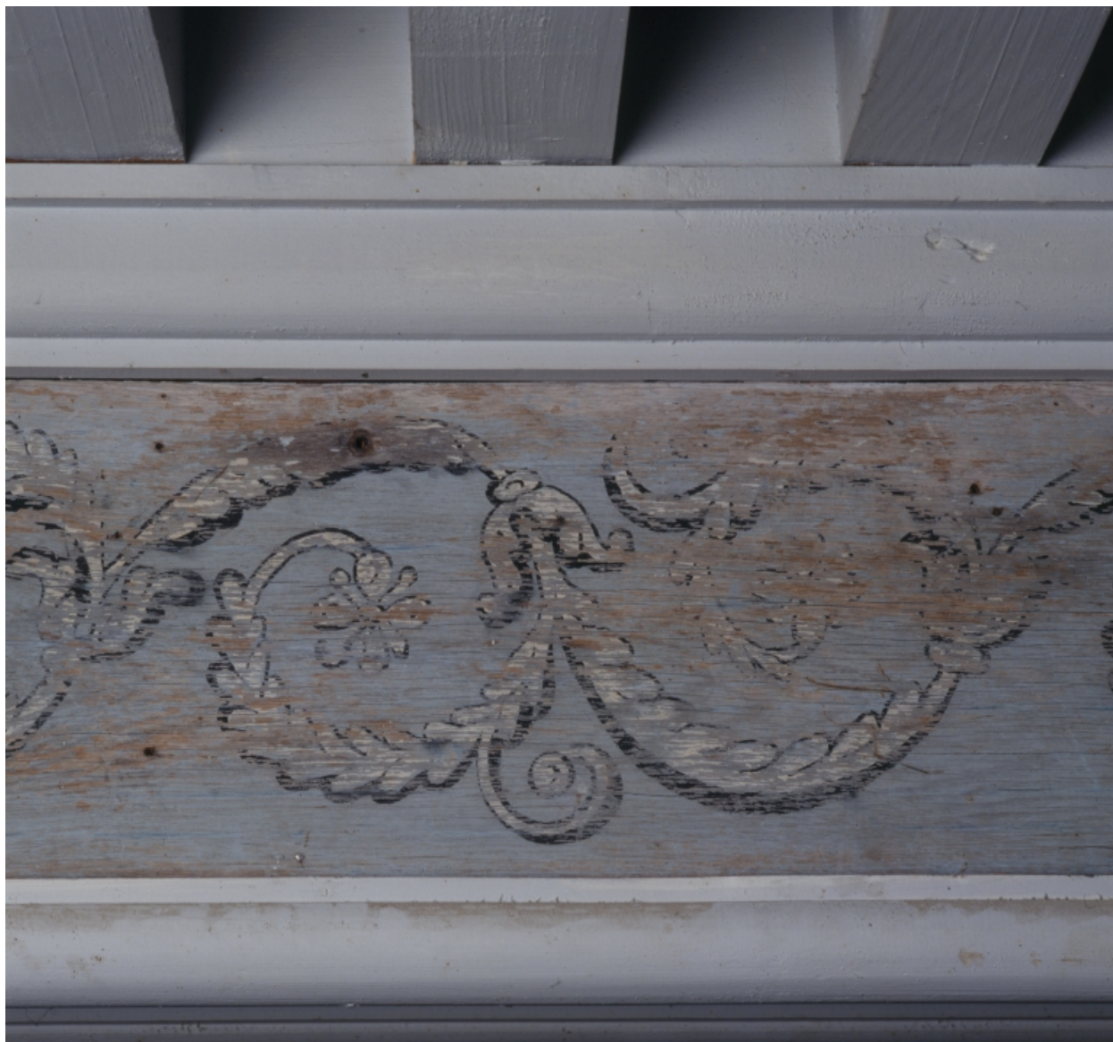
Corps de logis nord-est, premier étage, salle dite du Grand Juge située au nord : détail intérieur des rinceaux peints sur les poutres.
