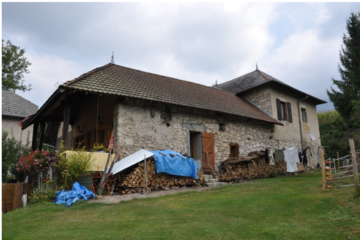
Vue générale, façade sud
