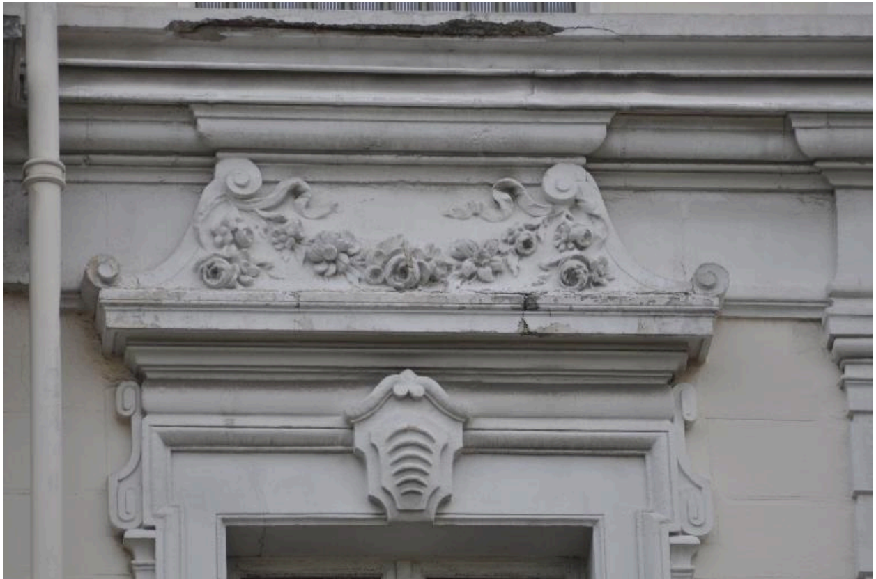
Détail d'un dessus-de-fenêtre du 2nd étage
