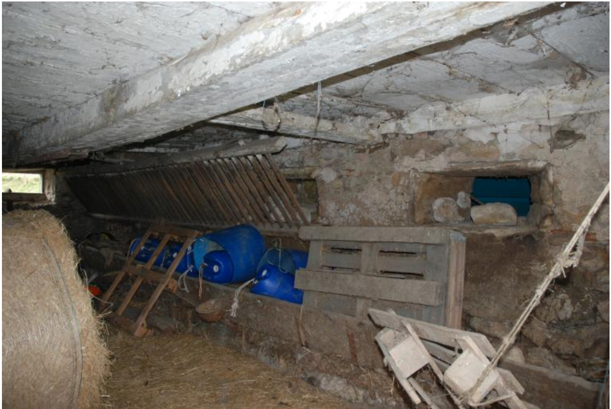
Vue intérieure de l'étable.
