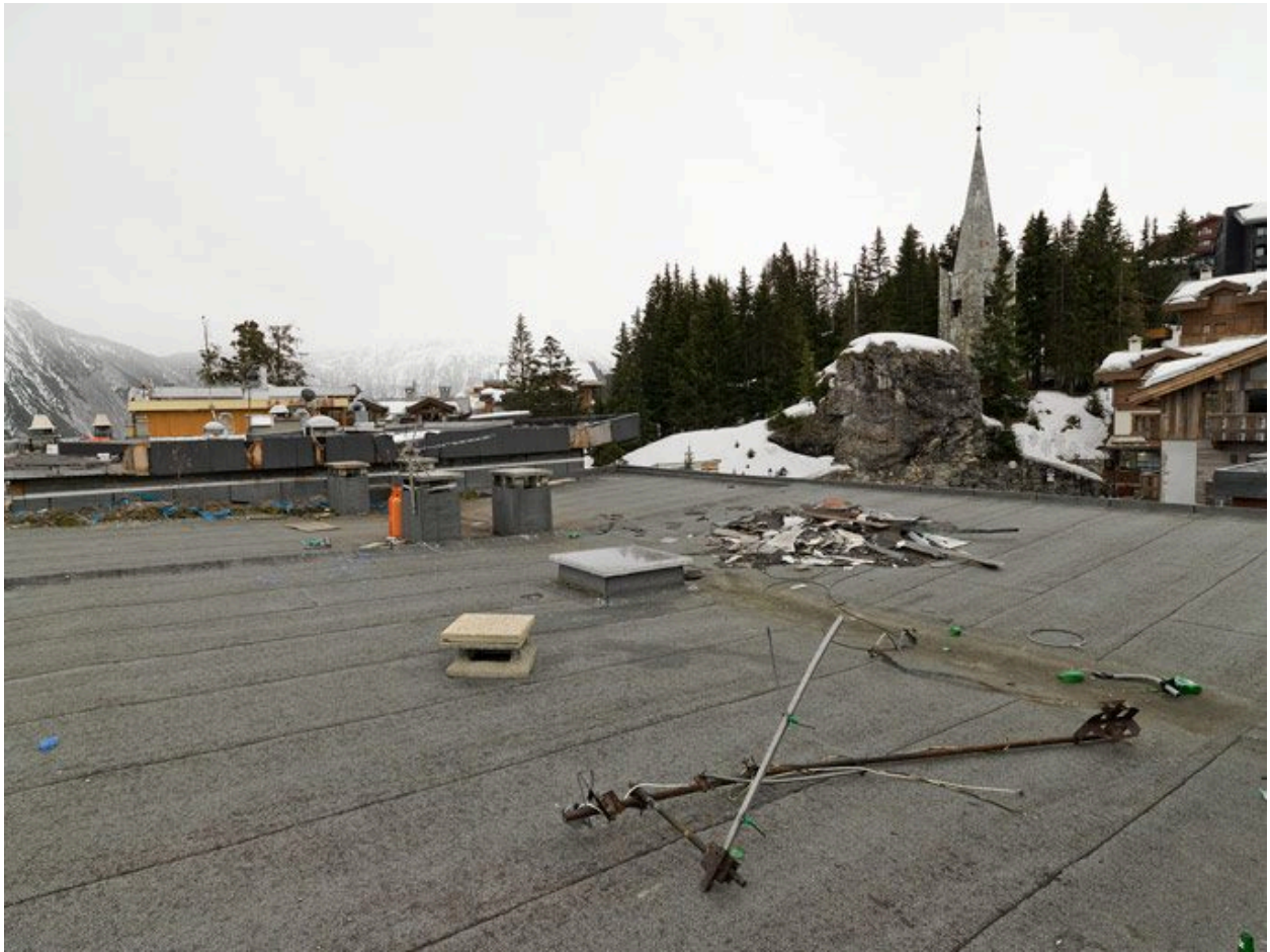
Toit terrasse d'un immeuble rue des Verdons
