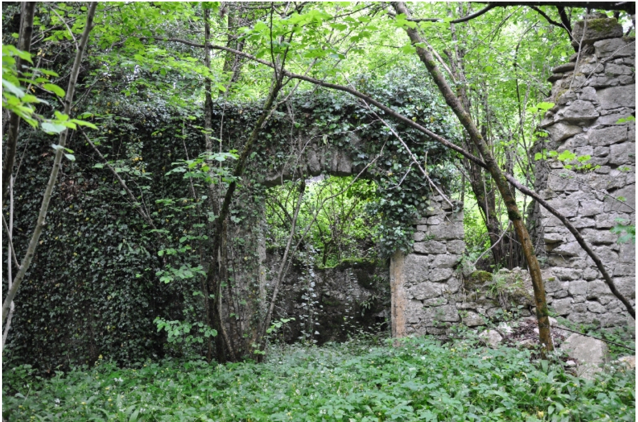
Façade ouest du moulin avec une ouverture en anse de panier
