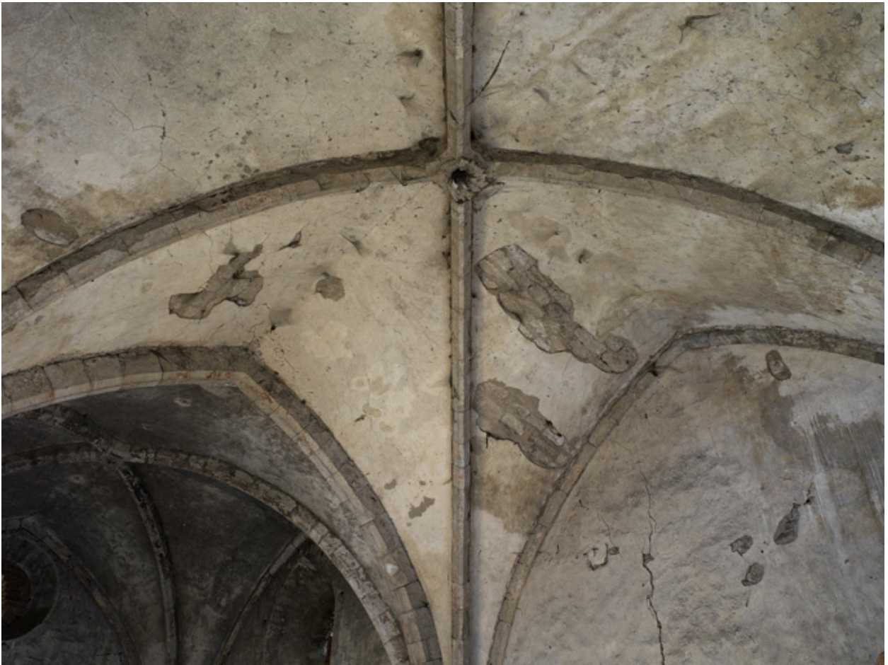
Détail des voûtes de la chapelle, première travée.
