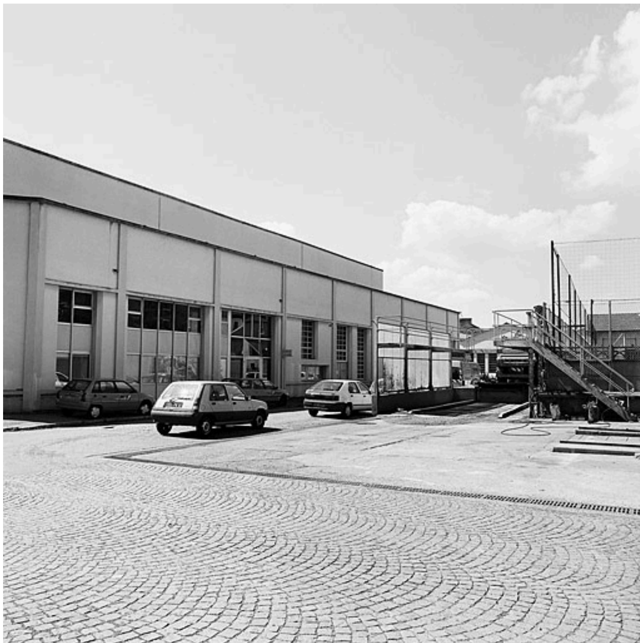
Annexe ouest du hall mécanique
