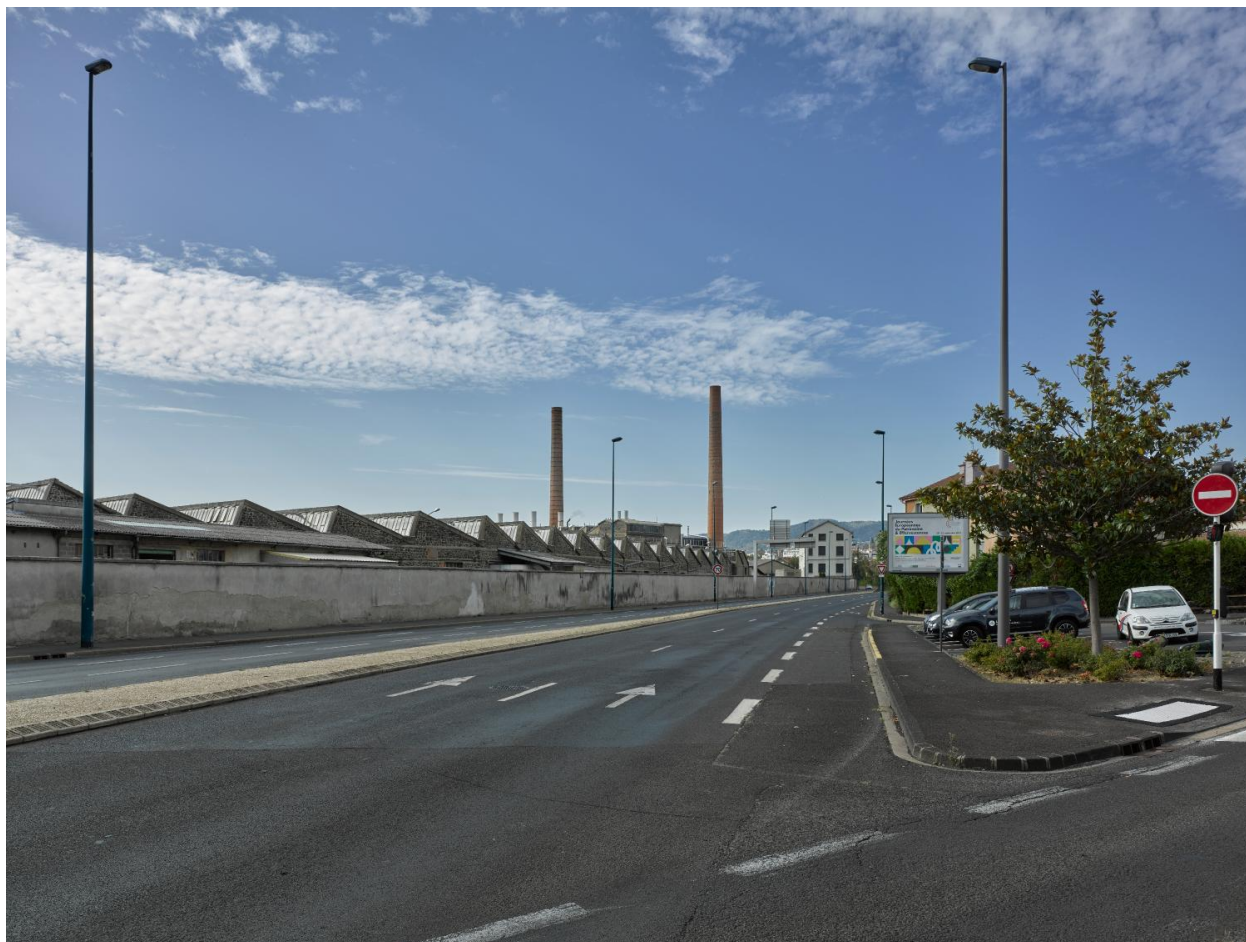
L'usine depuis l'avenue Fernand-Forest, en direction du sud-ouest : portion de l'usine faisant directement face à la cité ouvrière de Chanteranne.
