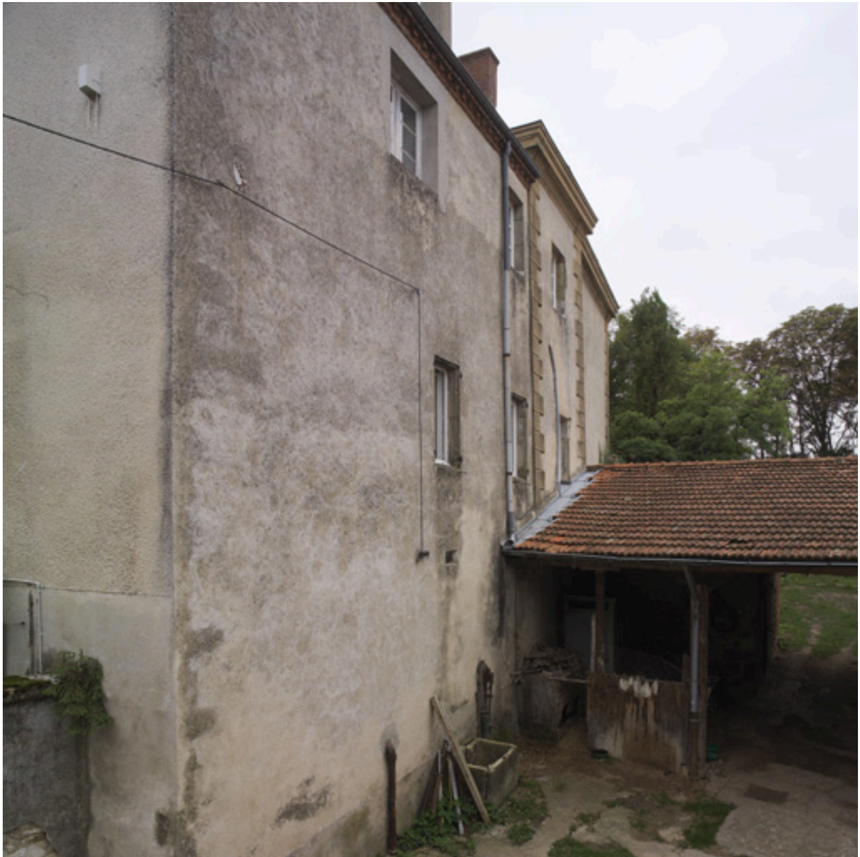
Vue de l'élévation nord, depuis le nord-est.
