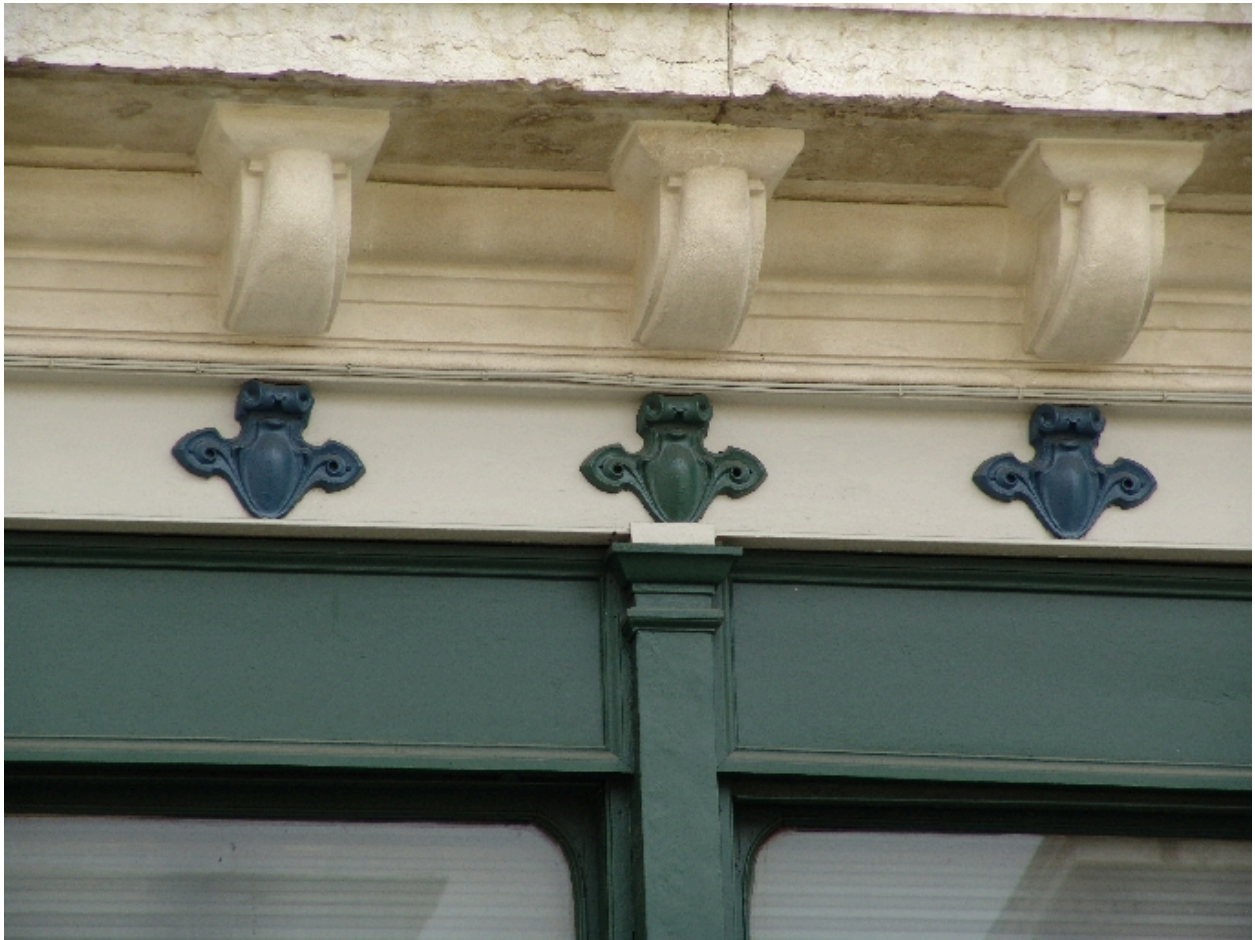
Détail d'une poutrelle métallique
