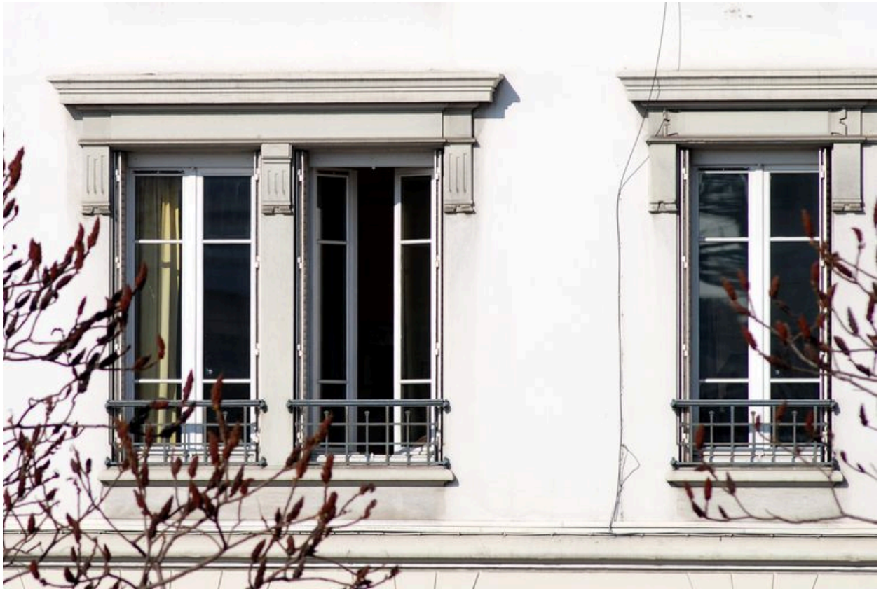
Elévation principale : vue des baies du second niveau
