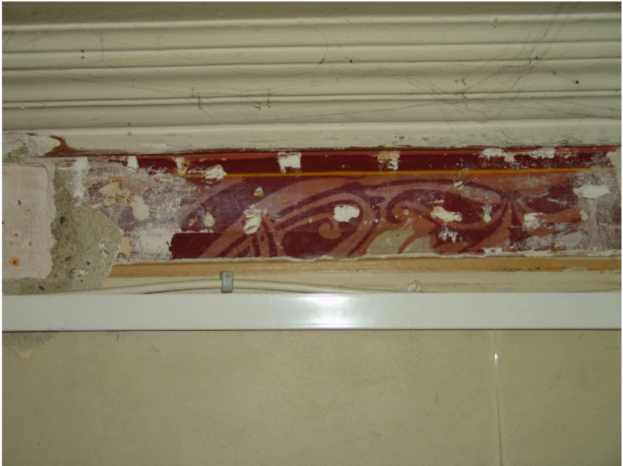
Vestige de frise dans la cage d'escalier
