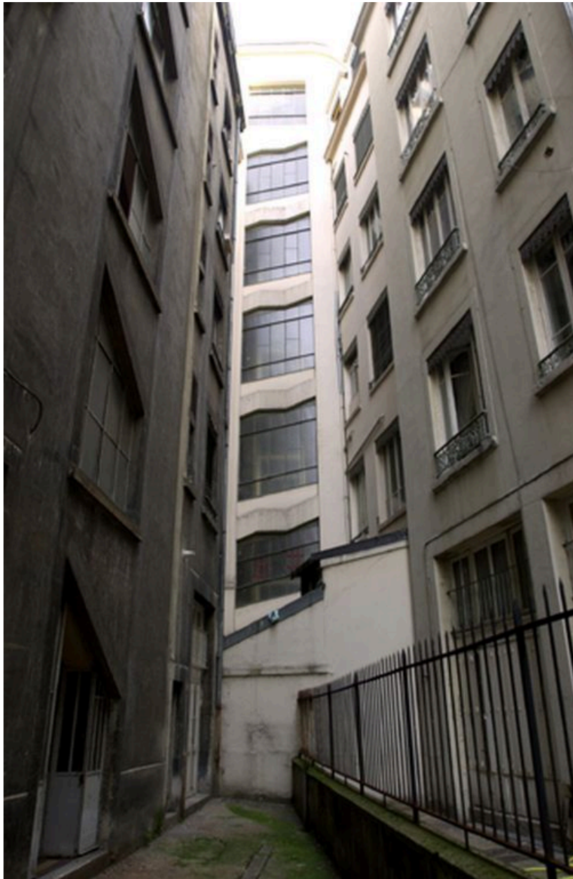
Elévation postérieure, vue de la travée d'escalier
