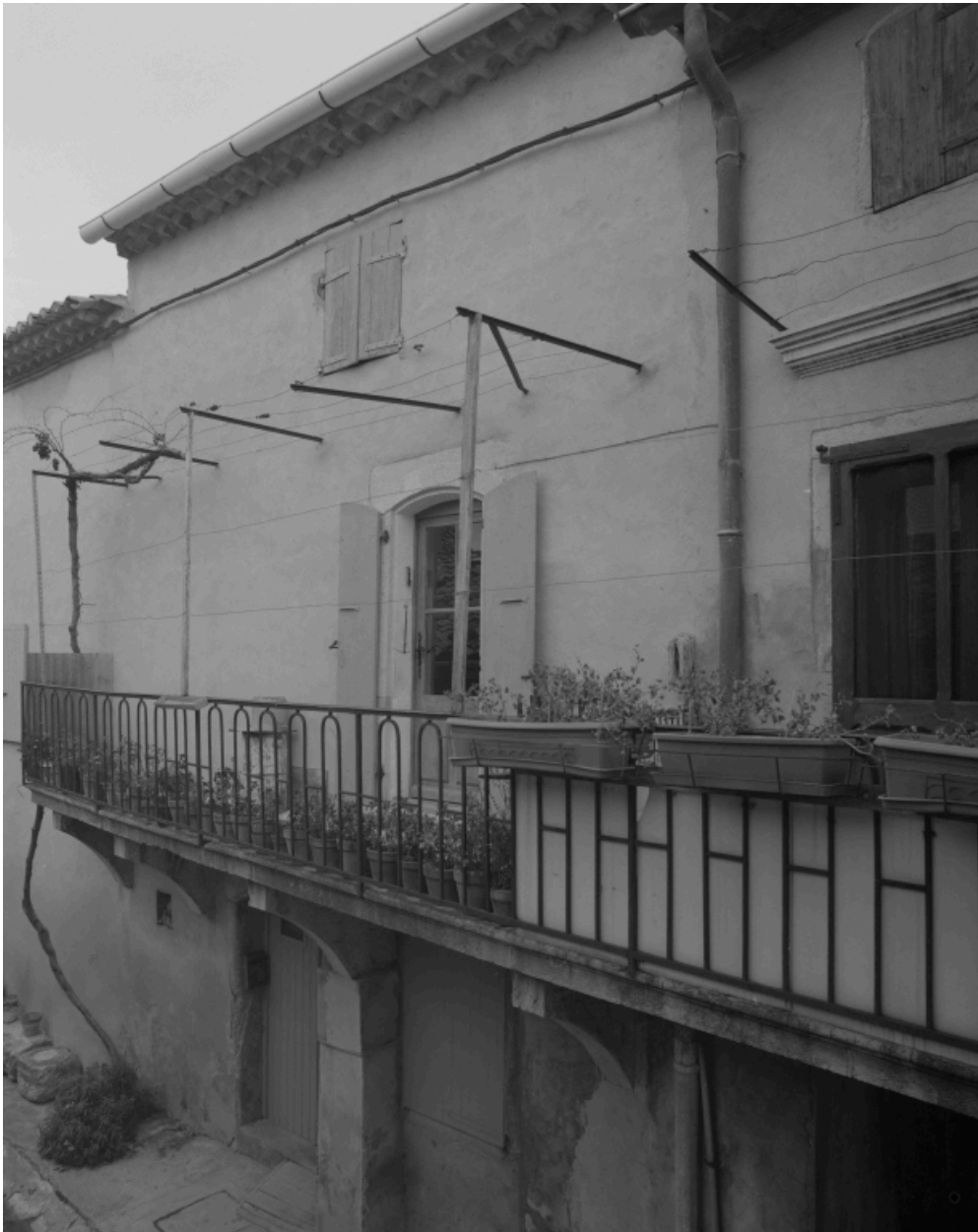
Vue partielle de l'élévation de la maison (B3 644) sur la Grand'rue.
