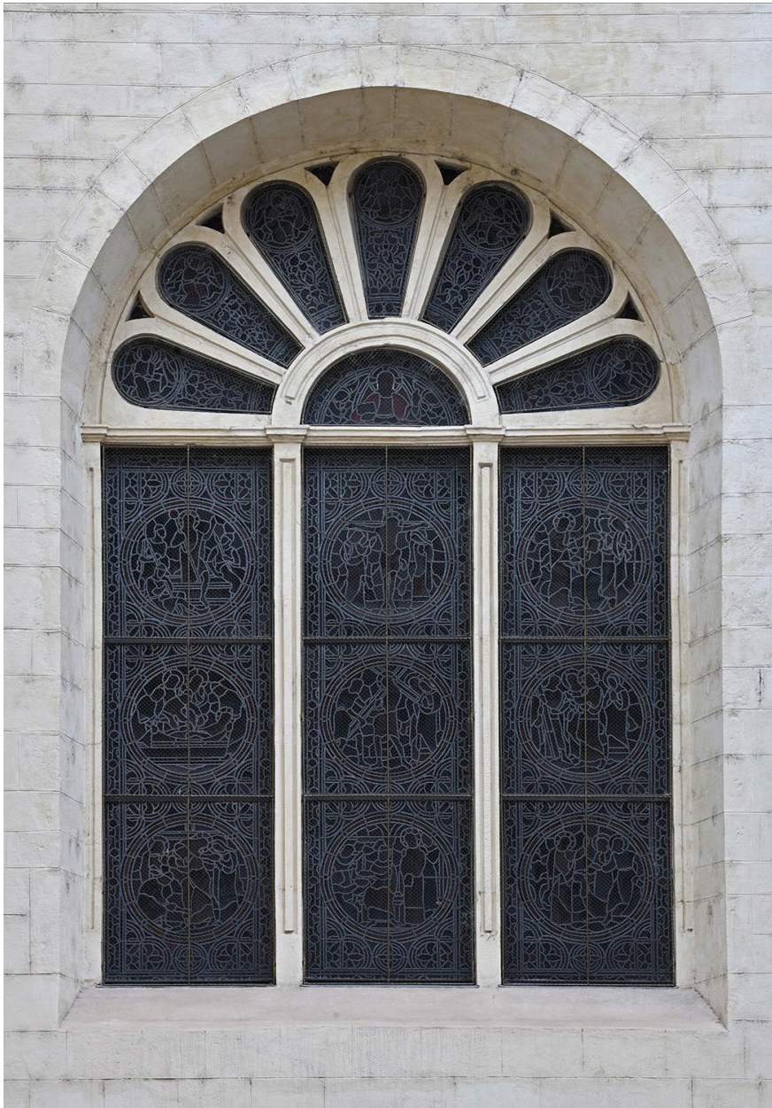
Elévation ouest, baie 9
