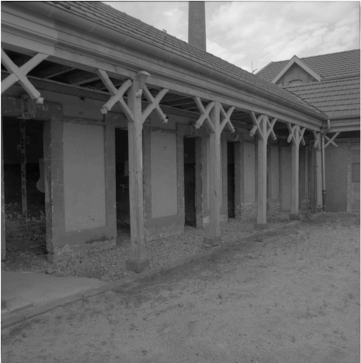
Vue partielle des bains - douches de l'aile gauche.
