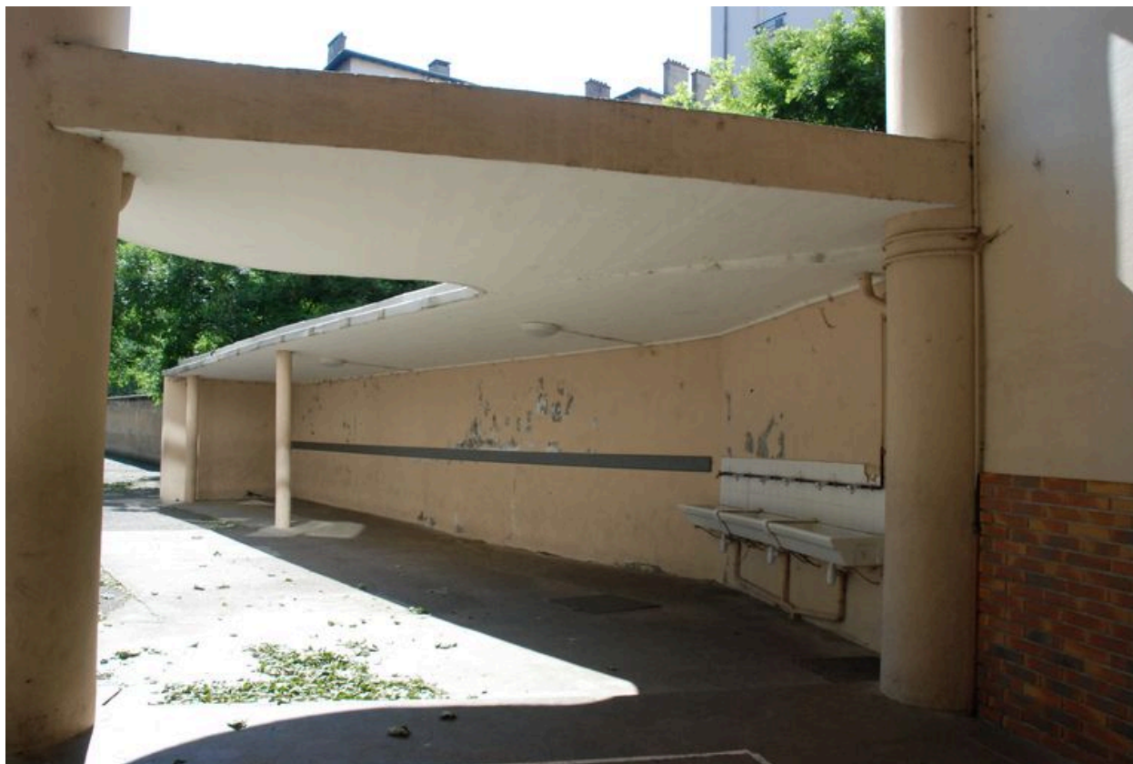
Vue du préau sud-est, détail
