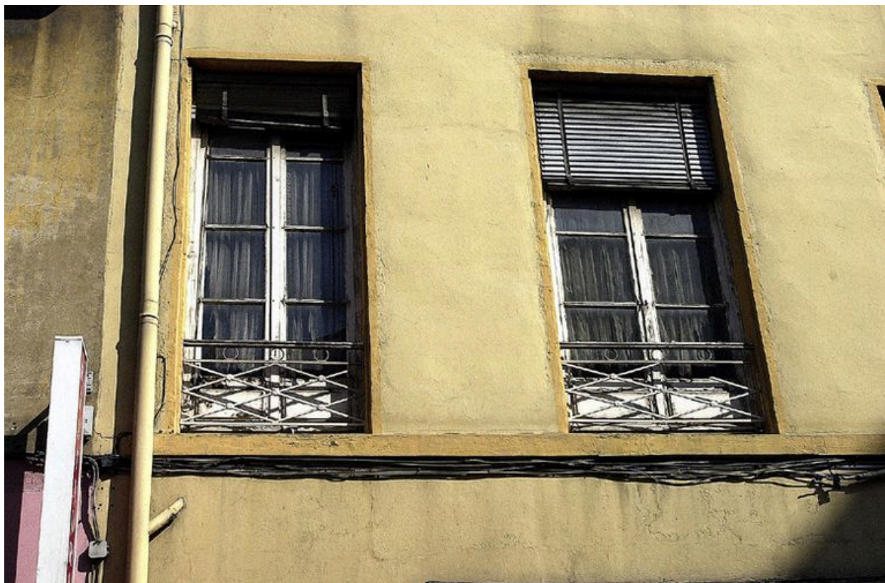
Détail de fenêtres
