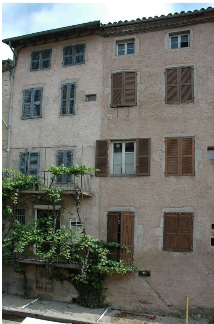
Elévation postérieure, du côté de la rivière.
