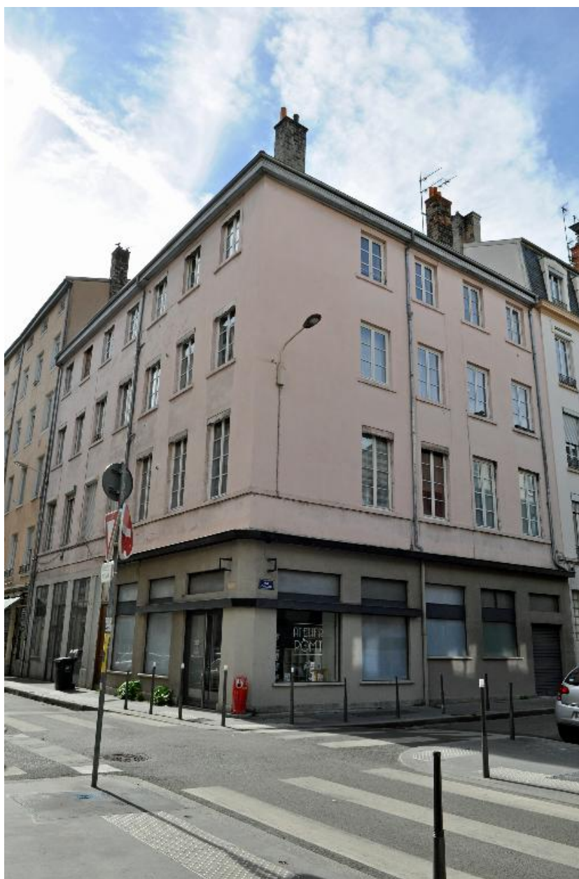
Vue générale, depuis le nord-ouest
