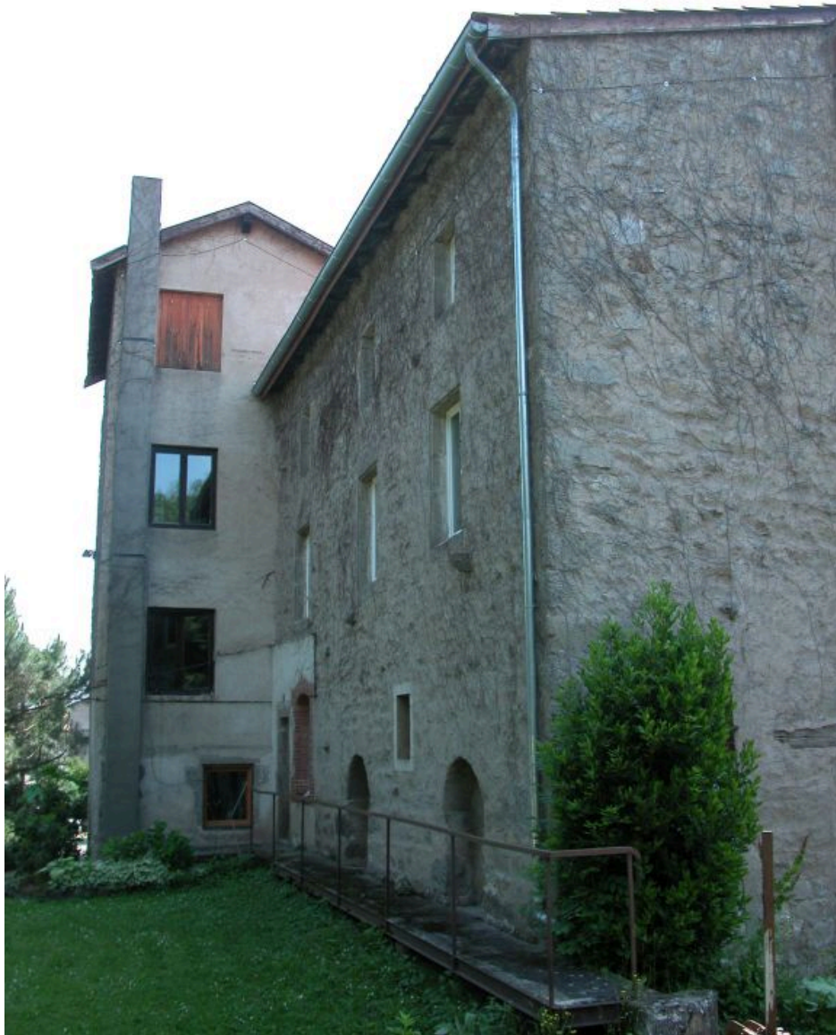
Enfilade de la façade nord-ouest du moulin depuis l'ouest.
