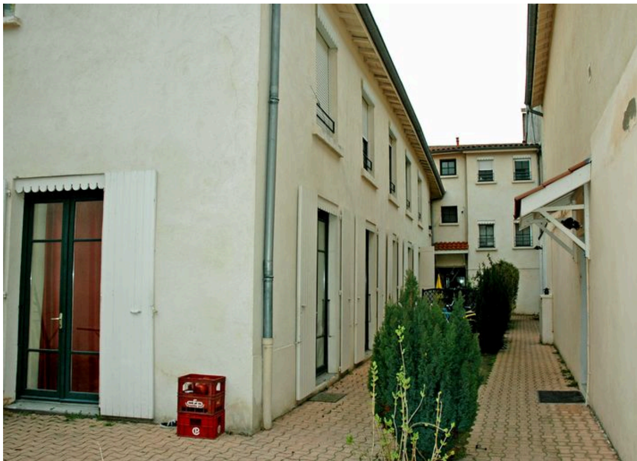
Façade nord vue depuis le nord-est de la cour
