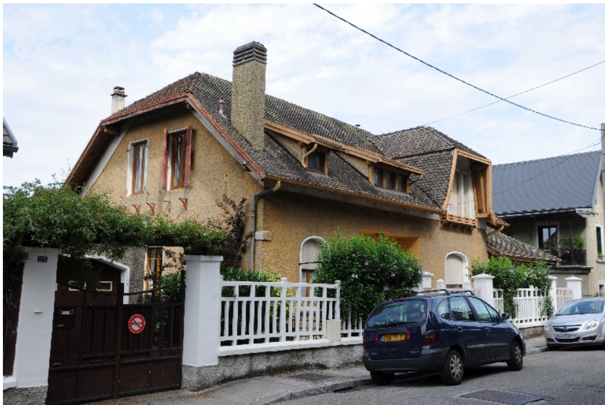
Vue générale depuis le sud
