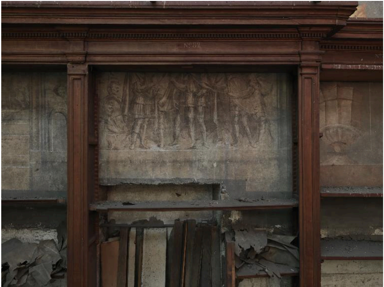
Mur nord, partie inférieure centrale
