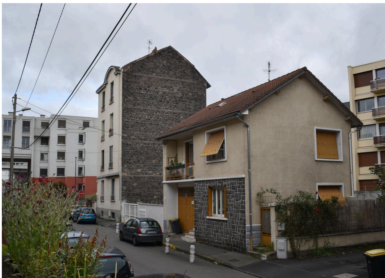
Façades sur la rue Philippe-Glangeaud
