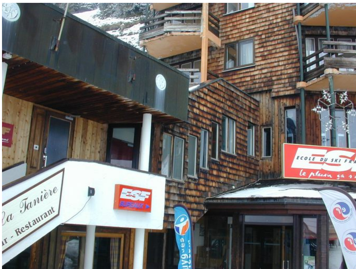
Détail de l'entrée sud du corps central
