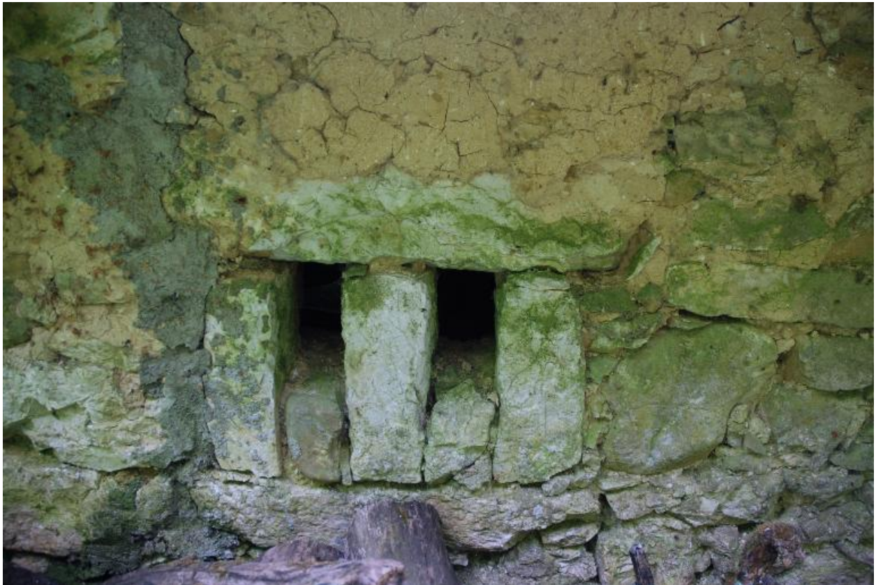
Détail de la façade postérieure : jour de l'étable.
