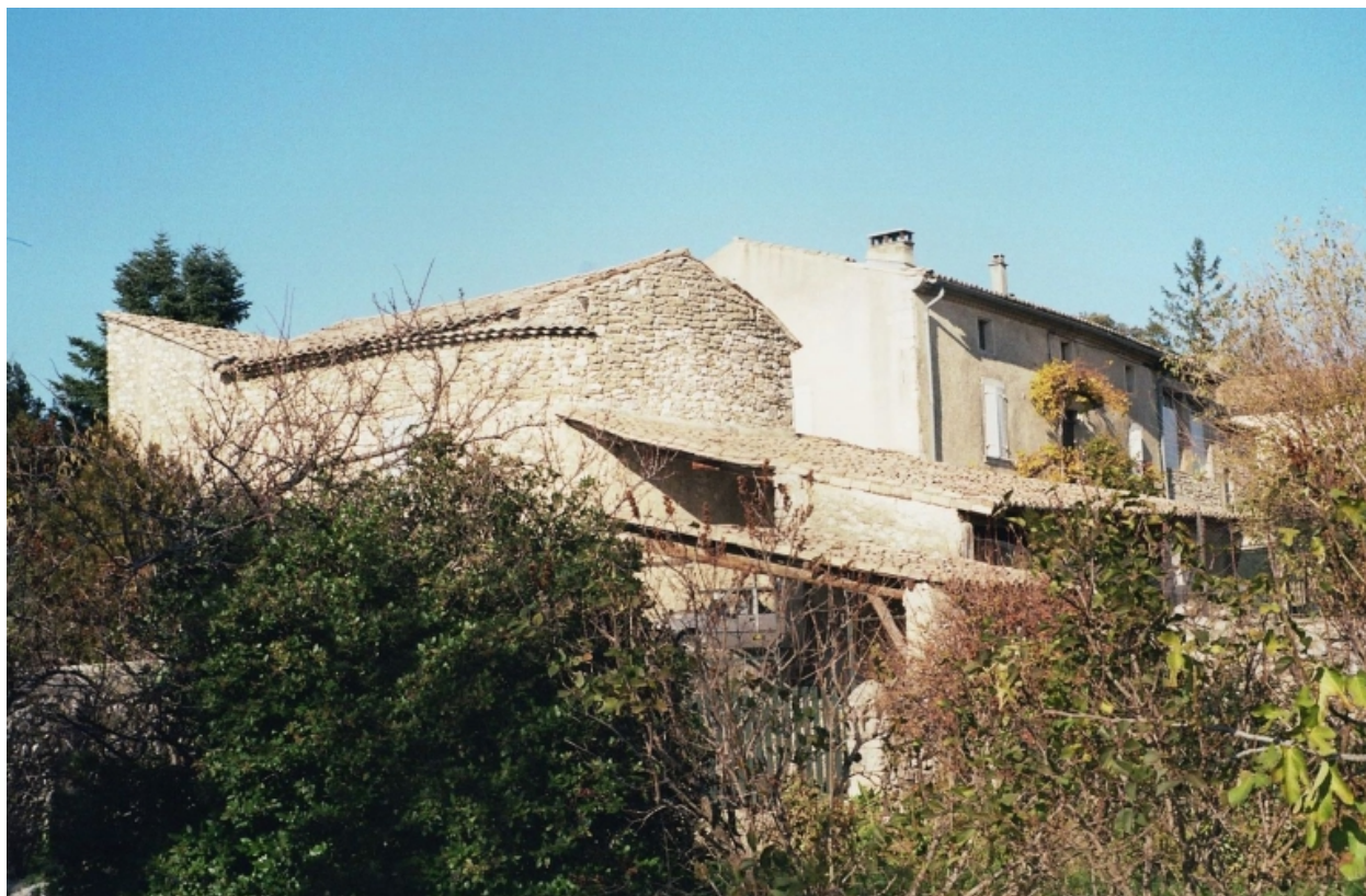
Vue d'ensemble de la maison cadastrée F 687, prise depuis la route d'Allan.
