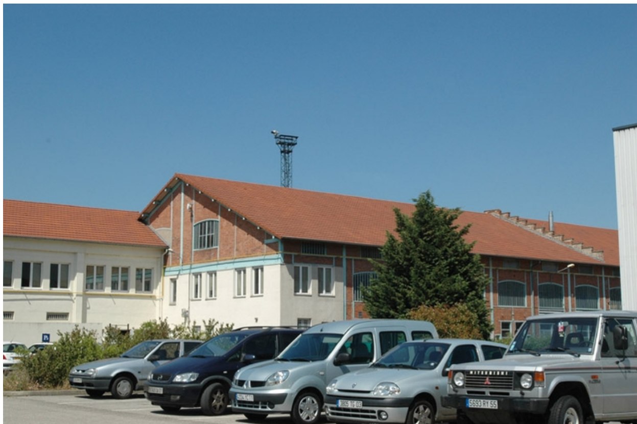
Vue nord des bâtiments n° 14 et 15
