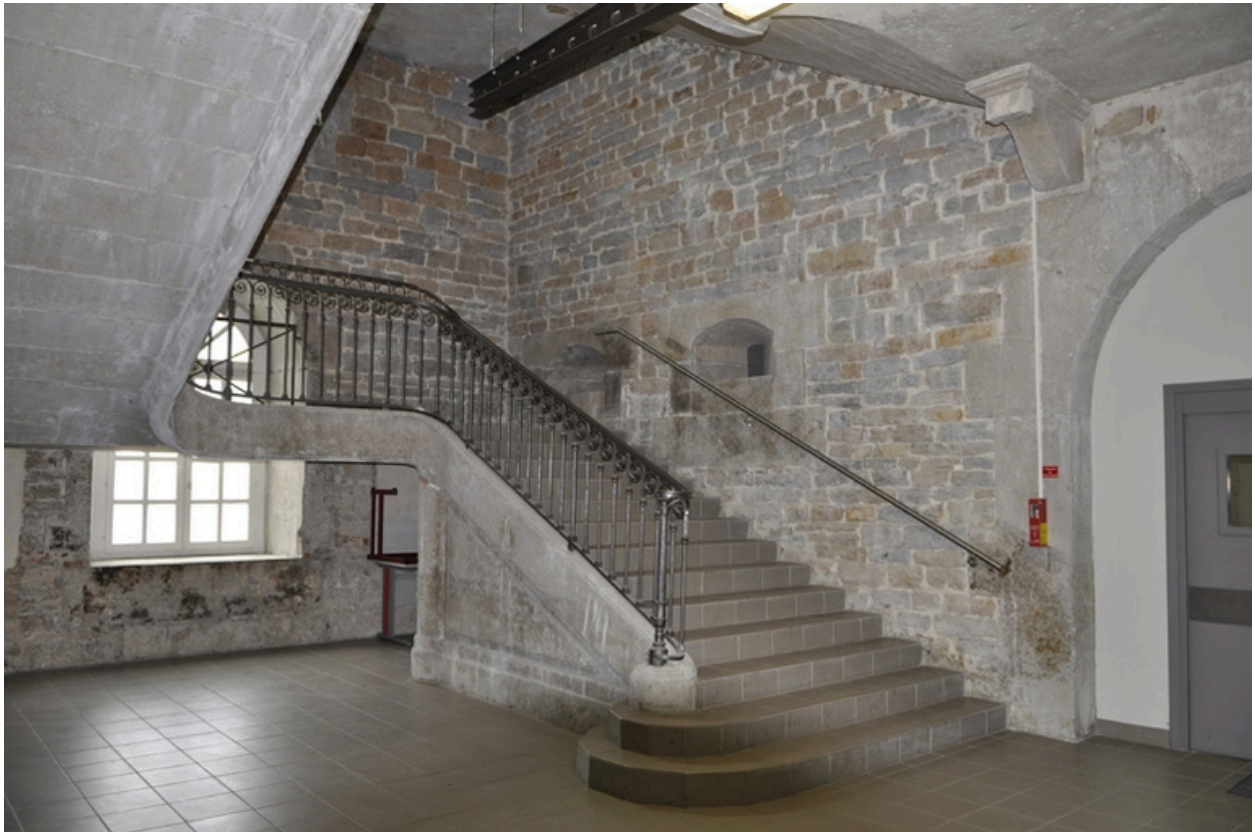
Vue de l'escalier principal 1er étage
