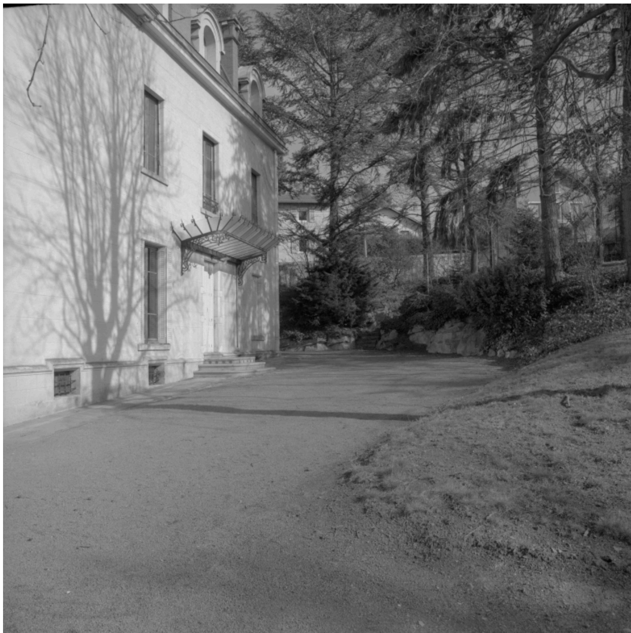
Vue de la façade sud de la maison, du sud-ouest.
