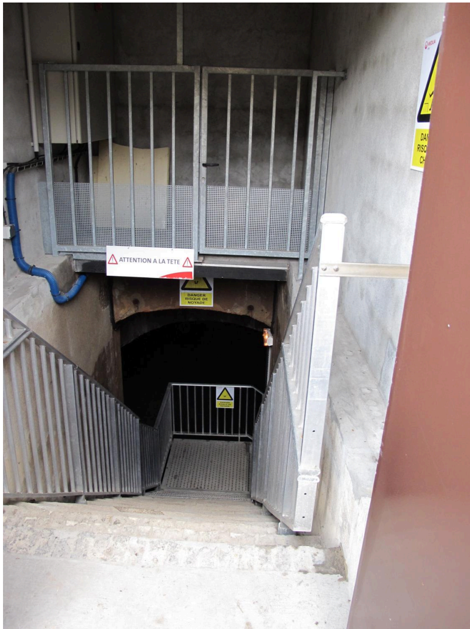
Escaliers pour l'accès aux bassins filtrants
