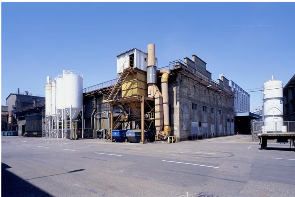
Fonderie, avenue C, ateliers et stockage.
