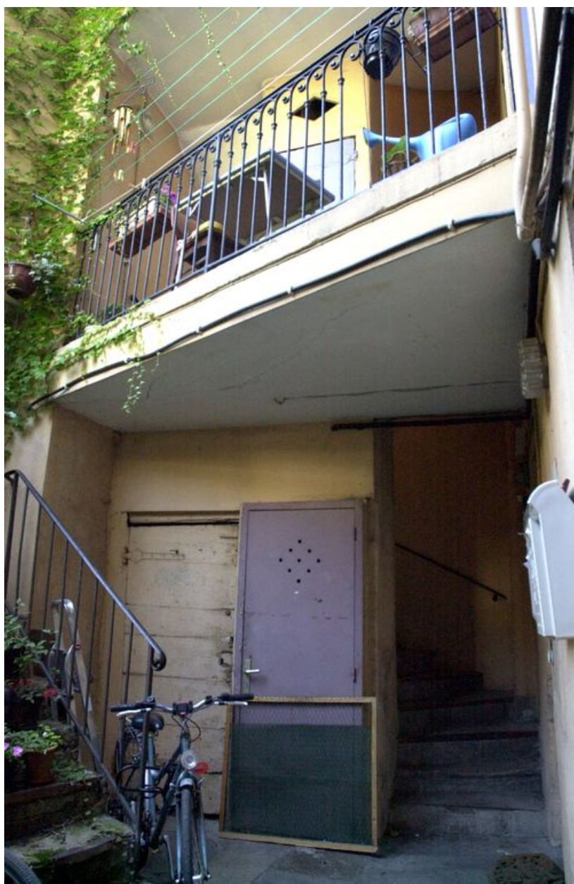
Coursière du 1er étage
